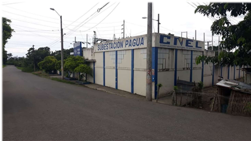
Gráfico 5.9. Subestación eléctrica Pagua
