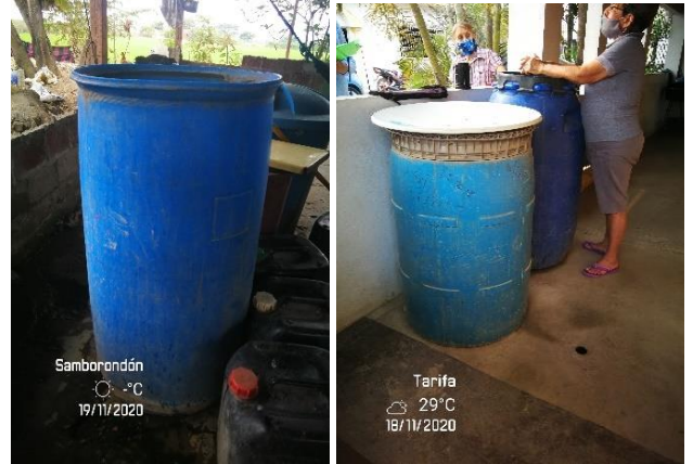
Foto 8. Tanques plásticos de 55 galones para recolectar el agua del tanque-cisterna o almacenar el agua adquirida al tanquero – recintos La Fortuna y Guarefirme.
