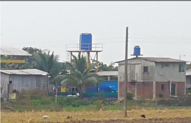
Foto 9. Sistema de agua tipo tanque elevado – Recinto El Carmen.
